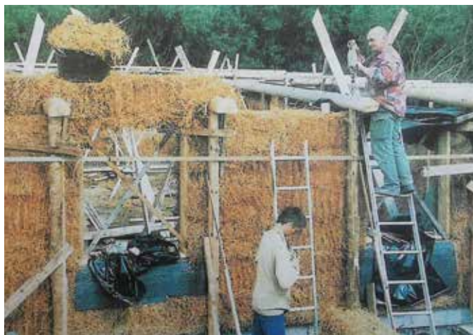
Rohbau eines Strohhauses in Dänemark mit Ständerkonstruktion.
